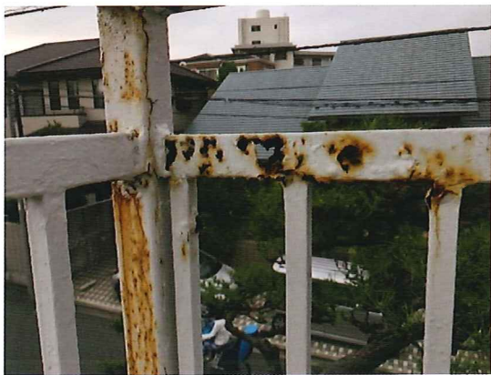
長年に渡り、風雨に耐えサビが進行しすぎて、一部では孔食も発生してしまっています。
