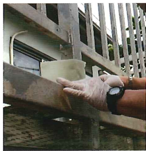
長年に渡り、風雨に耐えサビが進行しすぎて、一部では孔食も発生してしまっています。
