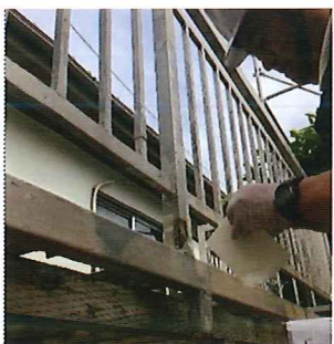
長年に渡り、風雨に耐えサビが進行しすぎて、一部では孔食も発生してしまっています。
