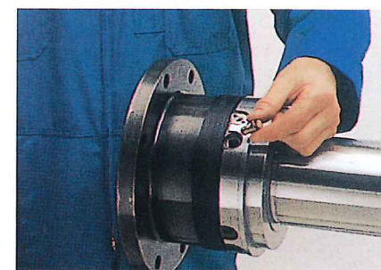
(1) 更换破损的剪切管。
