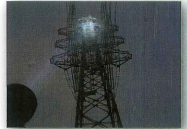
(HIDライト) 鉄塔上部まで明るく照射しています。
